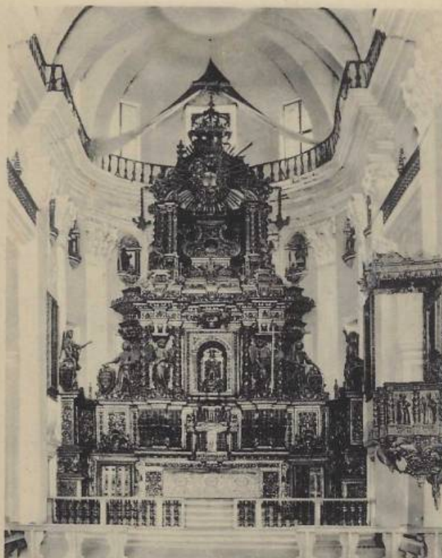
INTERIOR OF ST CAJETAN'S CONVENT GOA. (OLD CITY). INTERIOR DO CONVENTO DO S. CAETANO EM GOA. (VELHA CIDADE).
