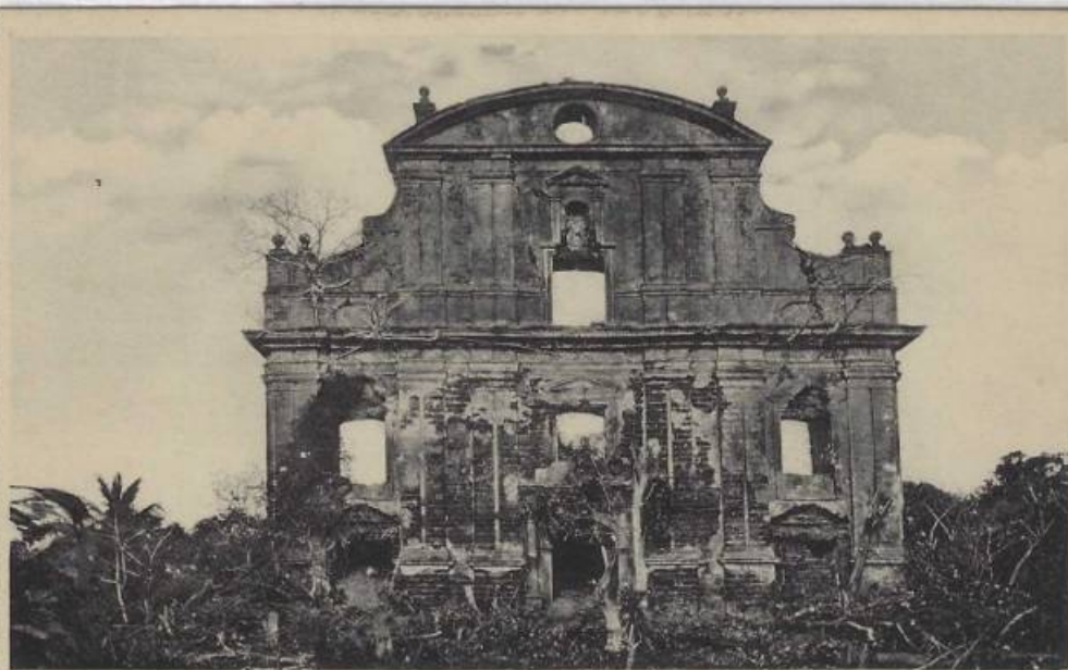
RUINS OF THE CONVENT OF OUR LADY OF M. CARMEL IN GOA. (OLD CITY). RUINAS DO CONVENTO DE N. S. DE CARMO EM GOA. (VELHA CIDADE).
